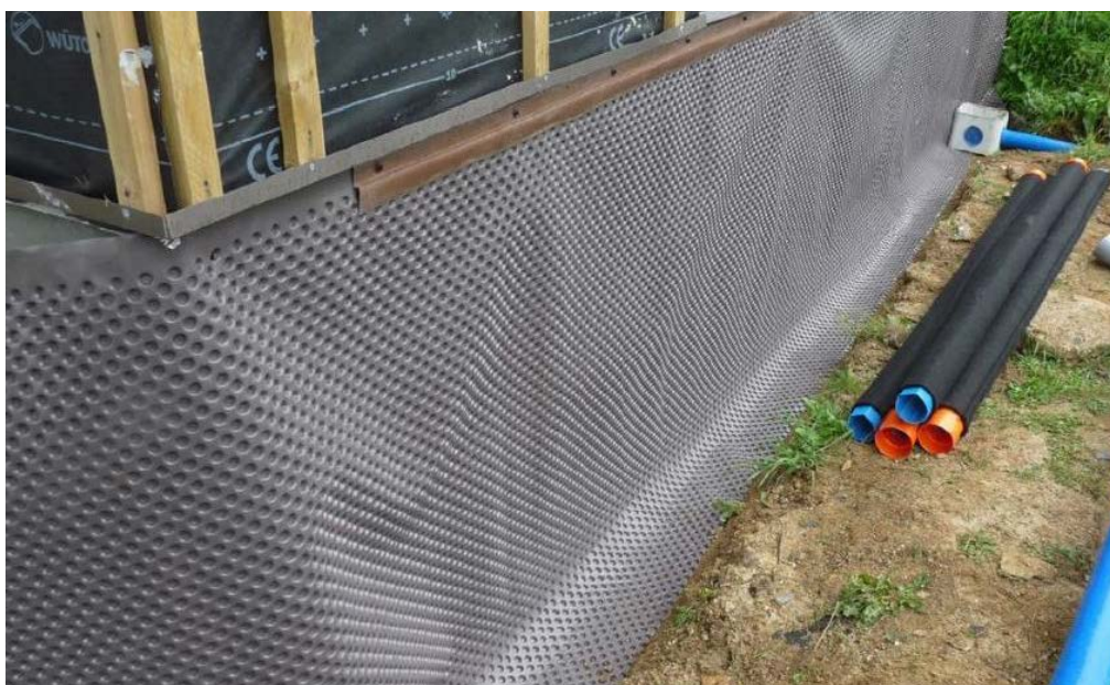
FIGURE N°13 : MISE EN OEUVRE D'UN FILM GAUFRE POUR PROTECTION DE L'ETANCHEITE
