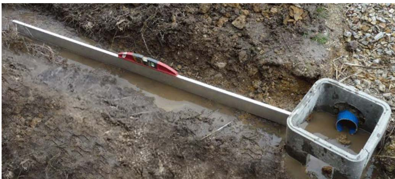
FIGURE N°14 : VERIFICATION DES PENTES AVANT LA MISE EN OEUVRE DU DRAIN BATIFIBRE® À DISTANCE DES FONDATIONS
