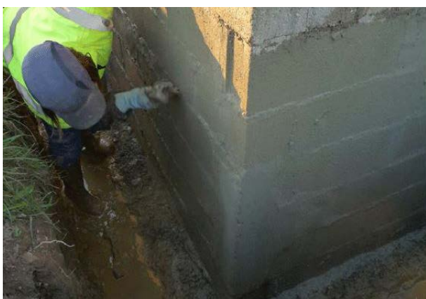
FIGURE N°12 : MISE EN OEUVRE D'UN PRODUIT D'ÉTANCHÉIFICATION
