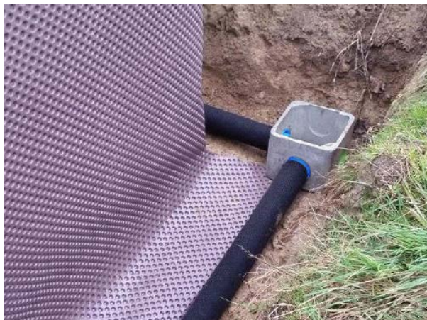
FIGURE N°18 : CHANGEMENT DE DIRECTION AVEC UNE BOÎTE D'INSPECTION
