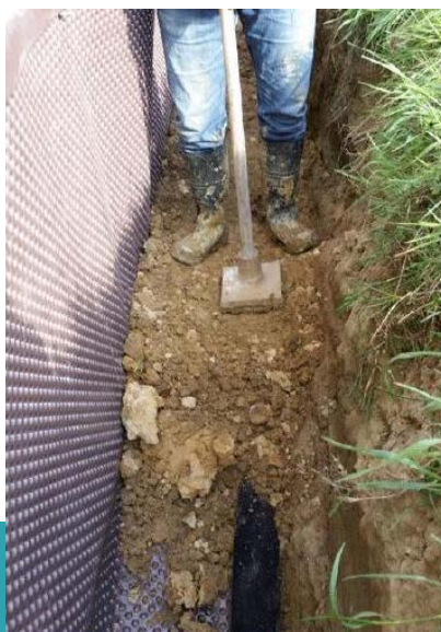
FIGURE N°32 : DAMMAGE MANUEL DES COUCHES DE REMBLAIS
